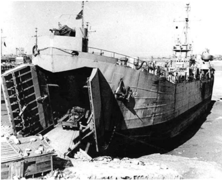
Ryc. 3. Okręt desantowy LST-750 w Inczon w październiku 1950. W czasie odpływów osiadał on na polach błot pływowych. Źródło: US National Archives.
